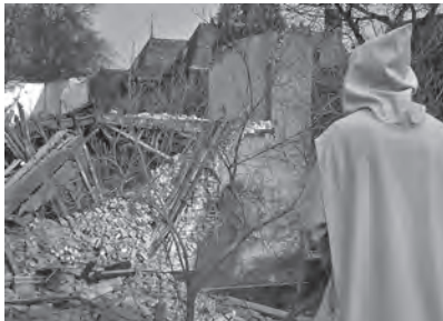
Abbruch der Klostergebäude.
